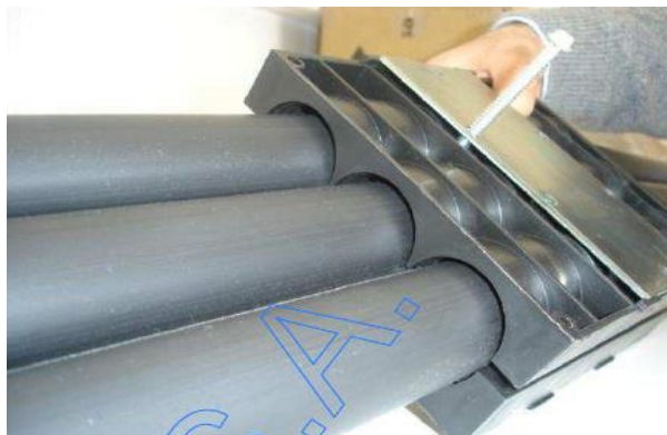
3.8 - União de tritubo através de acessórios eletro-soldáveis
