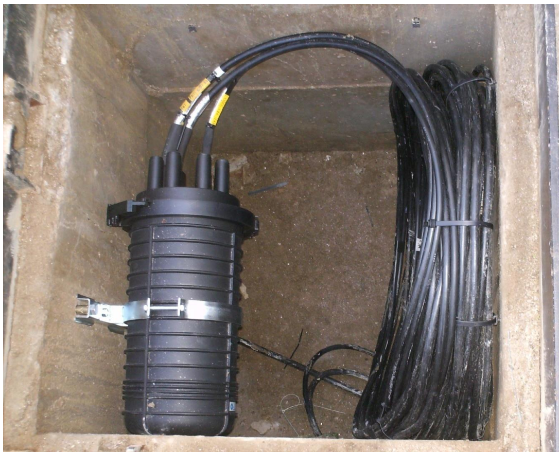
5.12 - Exemplo da instalação de uma junta de fibras óticas do tipo torpedo, no interior de uma caixa do tipo CVR1
